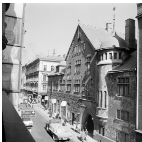
Regeringsgatan 38. Stockholms Gamla Elektricitetsverk. Brunkebergstationen foto Lennart f Petersen 1960
